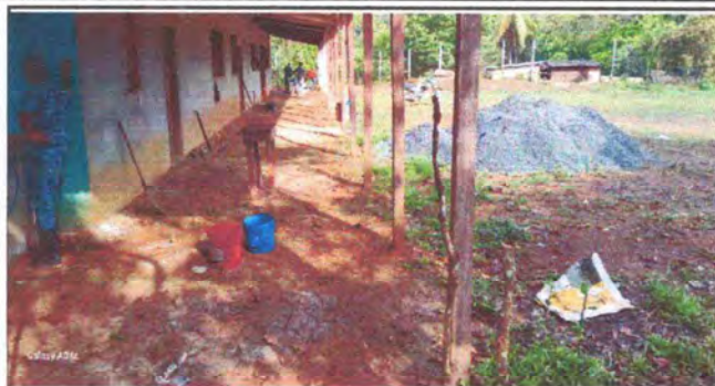
Foto 1: Asi se inicio el trabajo de remozamiento.
