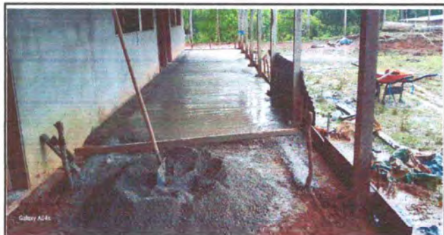
Foto 3: fundicion de piso del corredor.
